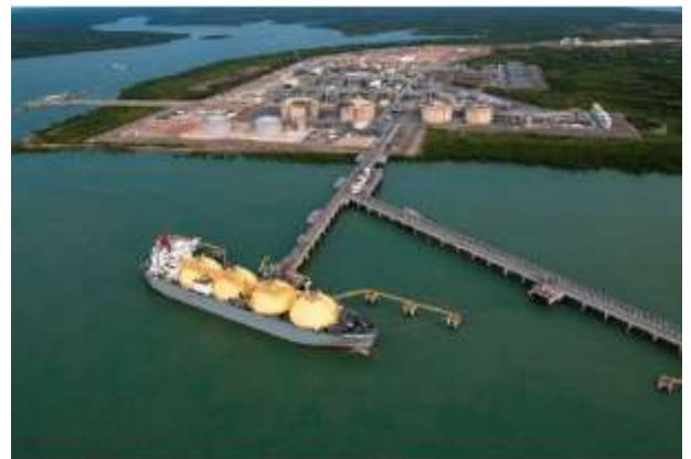
イクシス陸上ガス液化プラント
